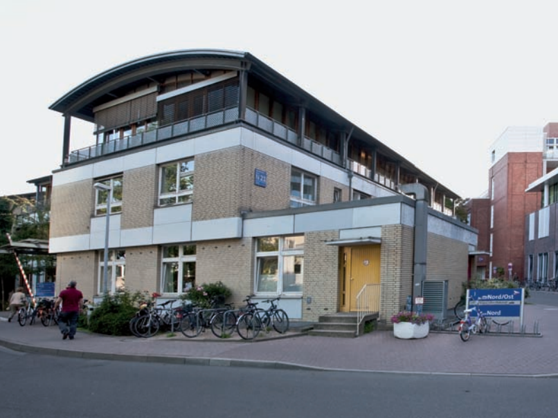
Abb. 32: Eingang ins Isolierzimmer von außen
